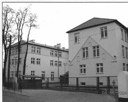
Szkoła po przebudowie.
